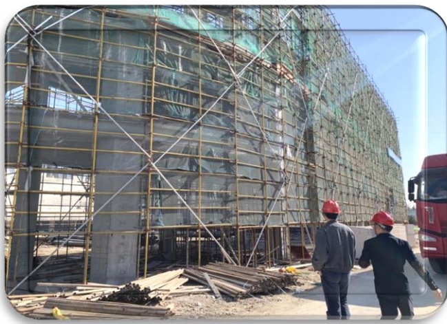
图 3-12：第三方中介机构对工程项目监督检查现场
